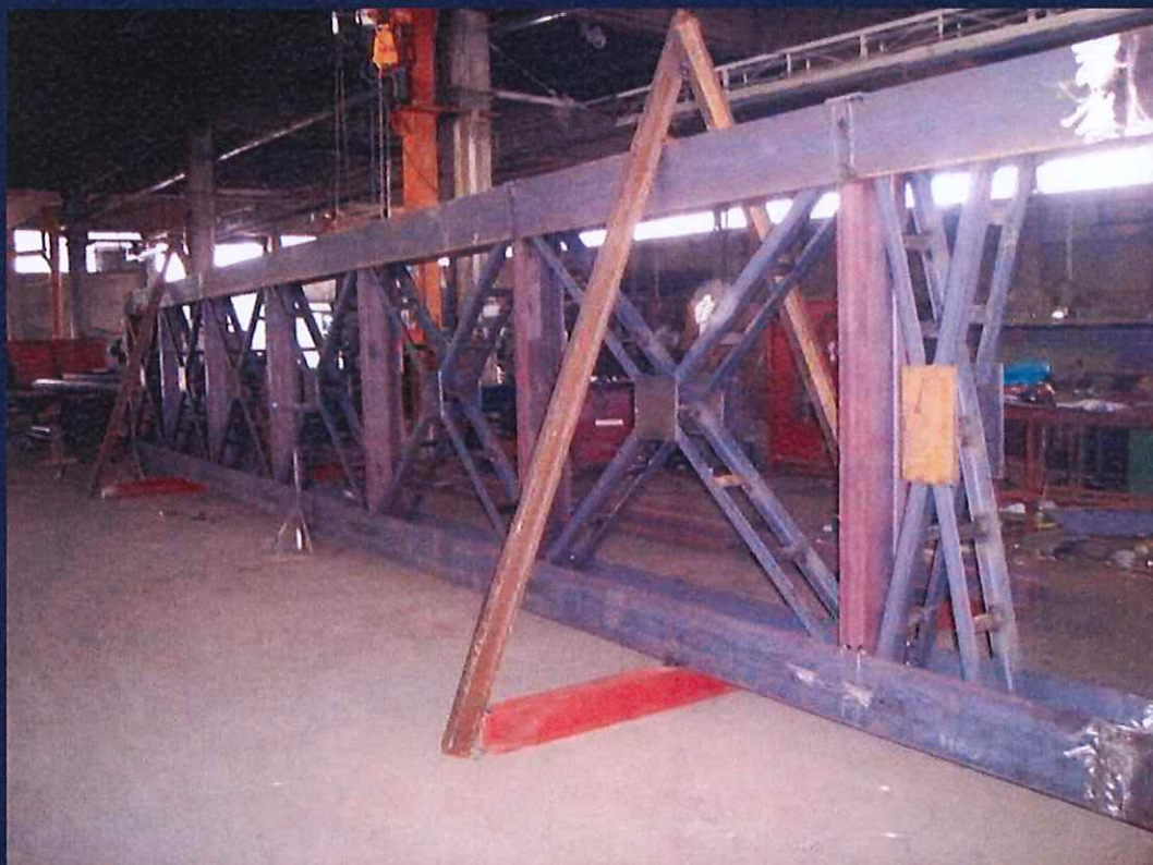
Realizzazione travi Reggi - Portoni c/o stabilimento Marghera (VE)
